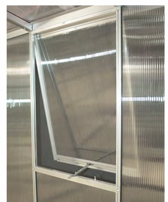
stěnové ventilační okno
