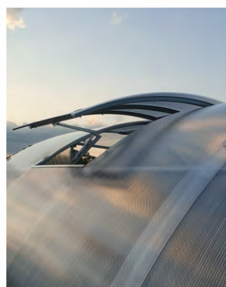
střešní ventilační okno
